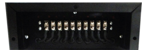
Bornera de conexión de entrada y salida
